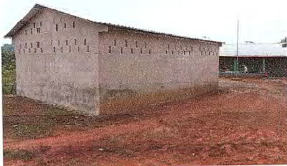
Foto 1: Fotografía de como quedó terminada la cocina
